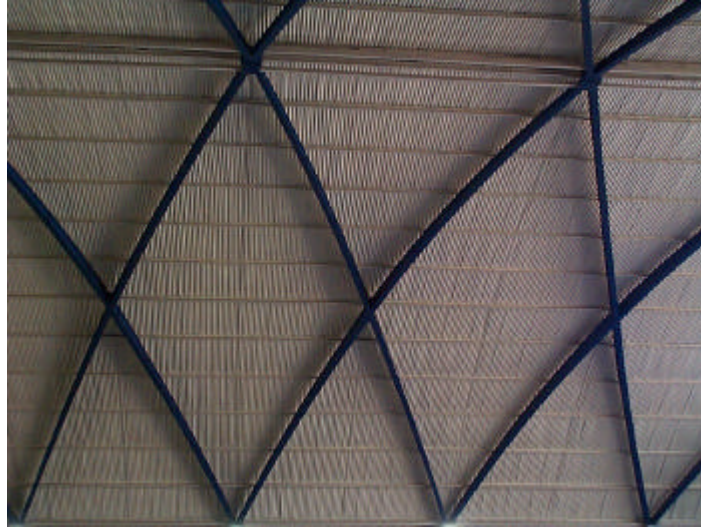
Figura 1.5. Detalle de la cubierta del Hangar de Cuatro Vientos. Proyecto de E. Torroja (1949).
