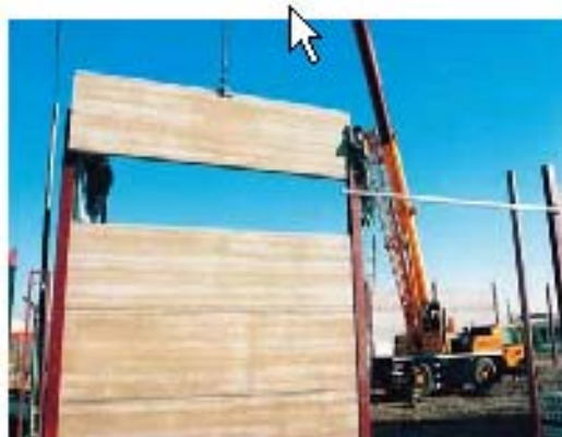
Figura 4. Montaje de placas de hormigón
