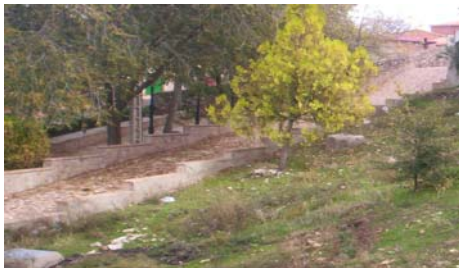
Foto: 2 Rampa tramo inclinado
