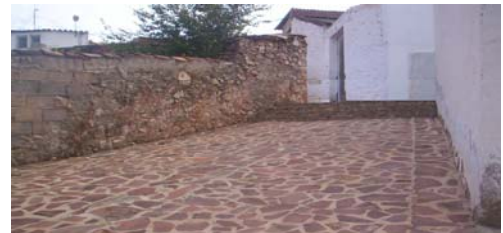
Foto: 3 Rampa, tramo llano, entrada por la calle
