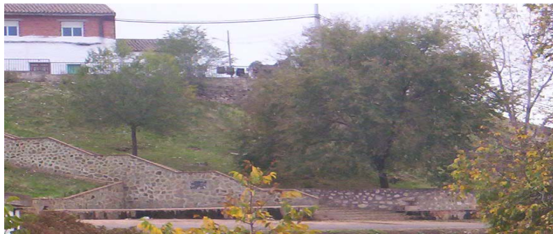
Foto: 1 Zona de la fuente
