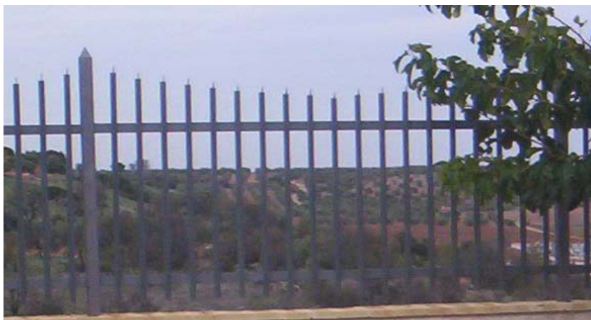
Foto: 143 “valla metálica (perfiles T 50. 6)”
