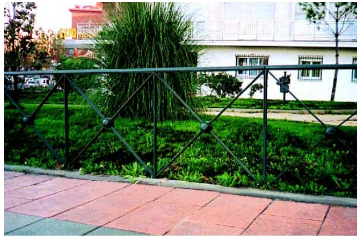
Foto: 144 “Valla metálica”
