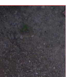
Pavimento terrizo, (explanación, refino y nivelación de terrenos por medios mecánicos)
